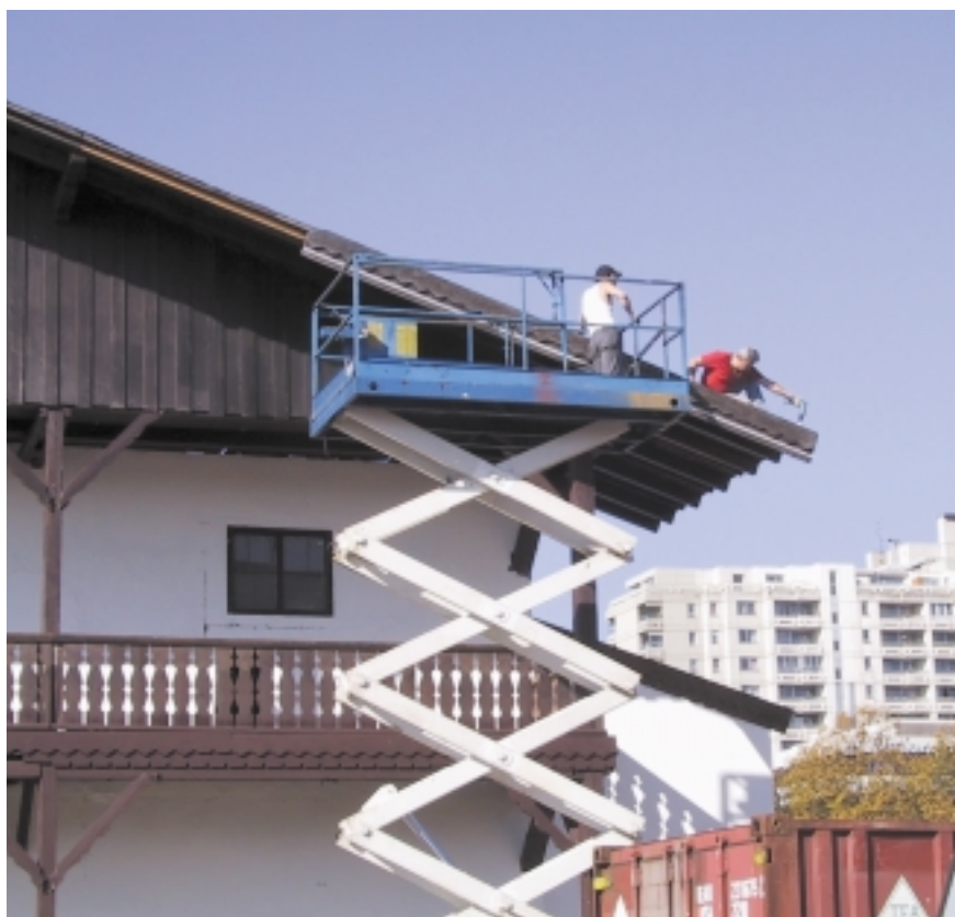
Abb. 1: Bierzeltbau mit Scherenhebebühne - und dennoch mit akuter Absturzgefahr
