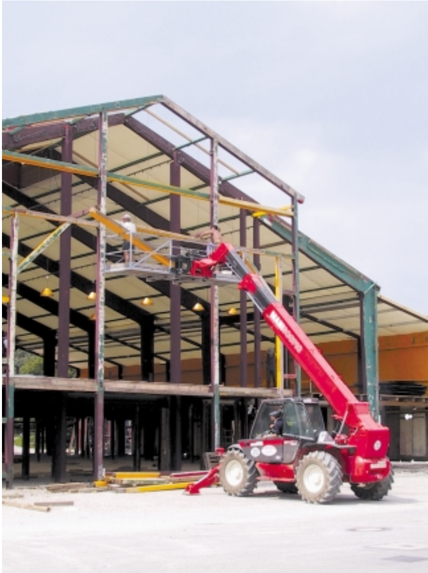
Abb.3: Zeltbauer in der Höhe - mit Teleskopstapler als sicherem Arbeitsmittel
