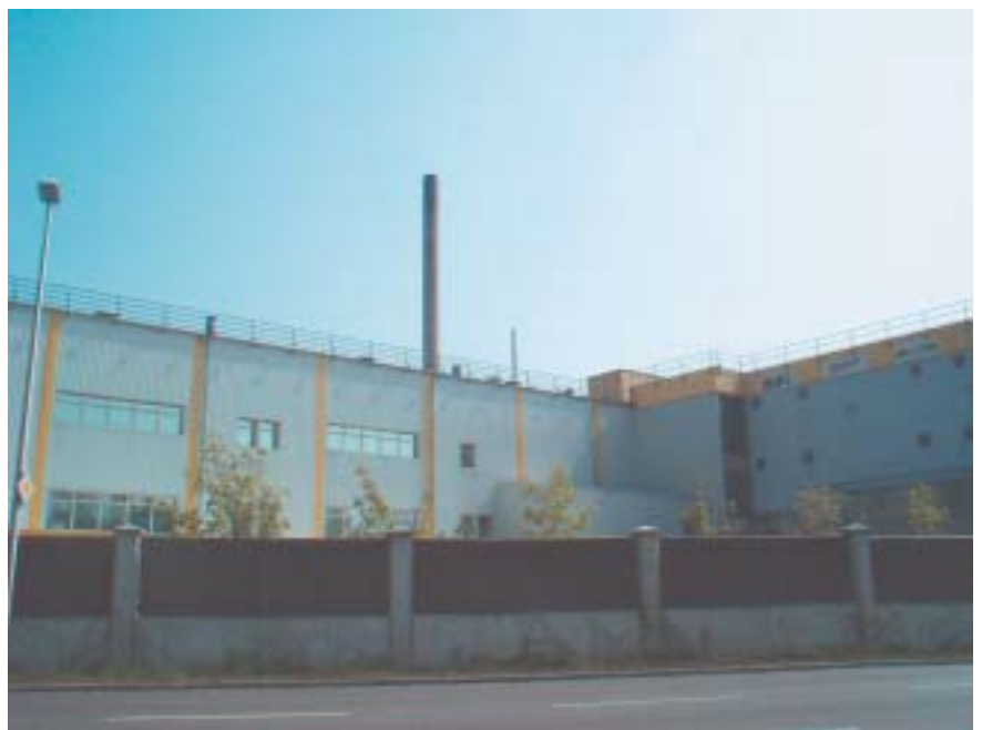
Abb. 1: Gegen Abstürze ordnungsgemäß abgesichertes Flachdach
