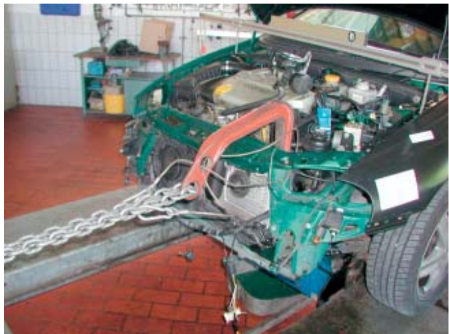
Abb. 1: Richtarbeit mit gesichertem Zughaken
