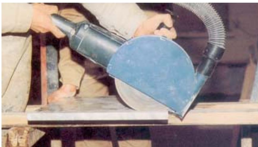
Abb. 2: Trennschleifer mit Absaugung zum Schneiden von Platten
