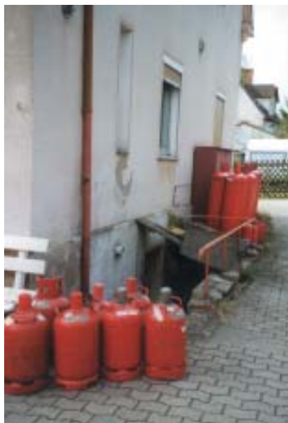
Bild 1: Unzulässige Lagerung am Kellerzugang
